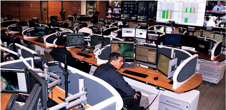
غرفة عمليات خدمات الطوارئ 999
