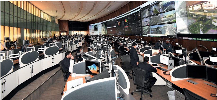
غرفة عمليات القيادة والسيطرة
